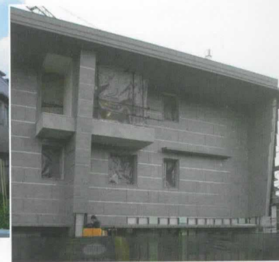
Viste dei fronti nord e sud dell'edificio dopo l'intervento di trasformazione.
