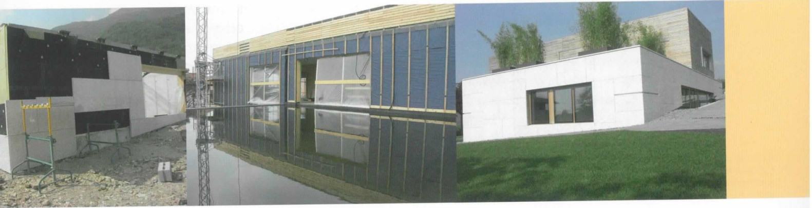
Sotto a sinistra e al centro, alcune fasi di cantiere. In dettaglio la costruzione della parete ventilata. Sotto, l'edificio alla fine dei lavori.
