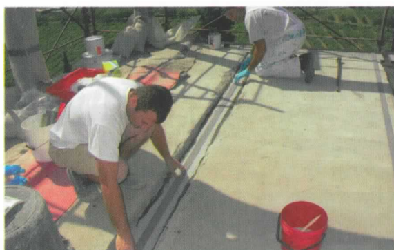
Posa delle lamine di rinforzo in fibra di carbonio.
