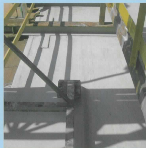
Superficie del tetto finita dopo l'impermeabilizzazione con Triflex ProTect.
