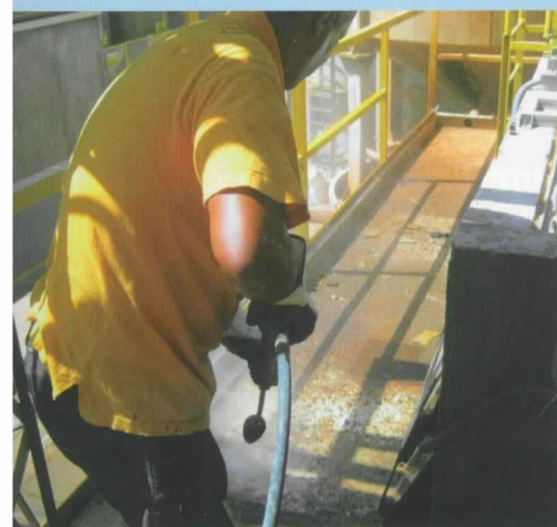
Preparazione del supporto mediante lavaggio con getto ad alta pressione.
