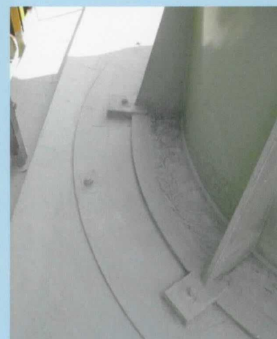
Particolare del basamento della torre dopo il risanamento impermeabile.
