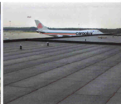
Malpensa Aeroporto (VA). Pensiline zona Cargo, impermeabilizzazione con membrane bituminose applicate a fiamma e linee vita.
