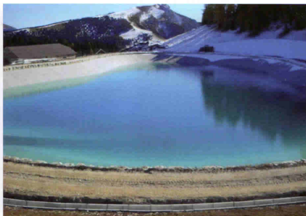
Passo Brocon (TN). Realizzazione di bacino per innevamento artificiale con membrana sintetica e protezione dei bordi fuori acqua.
