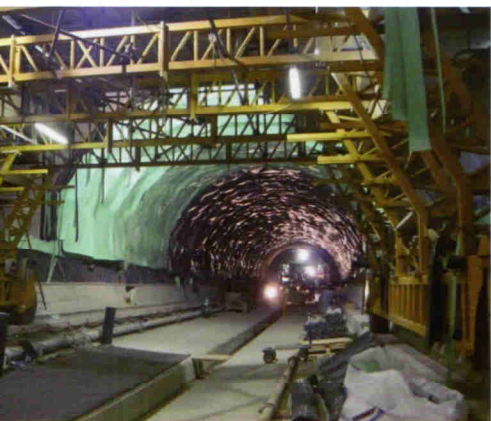
Monte Olimpino (CO). Impermeabilizzazione galleria parzialmente sottofalda con membrane sintetiche compartimentale per la verifica di tenuta.
